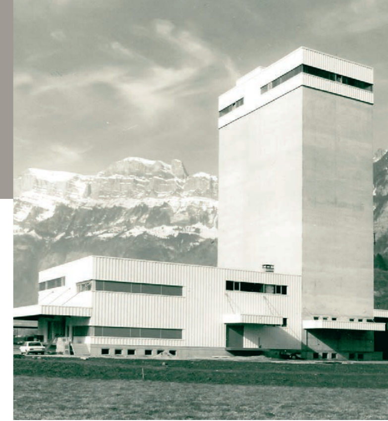
INBETRIEBNAHME DER FUTTERMÜHLE 1976
