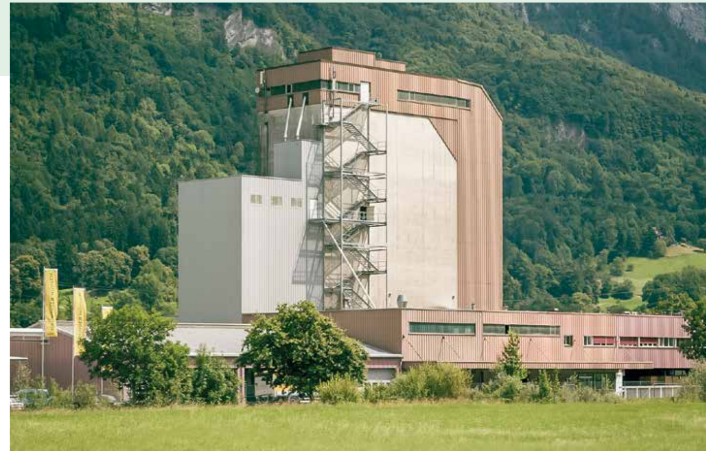
Futtermühle mit einer Leistung von 10t/1h
