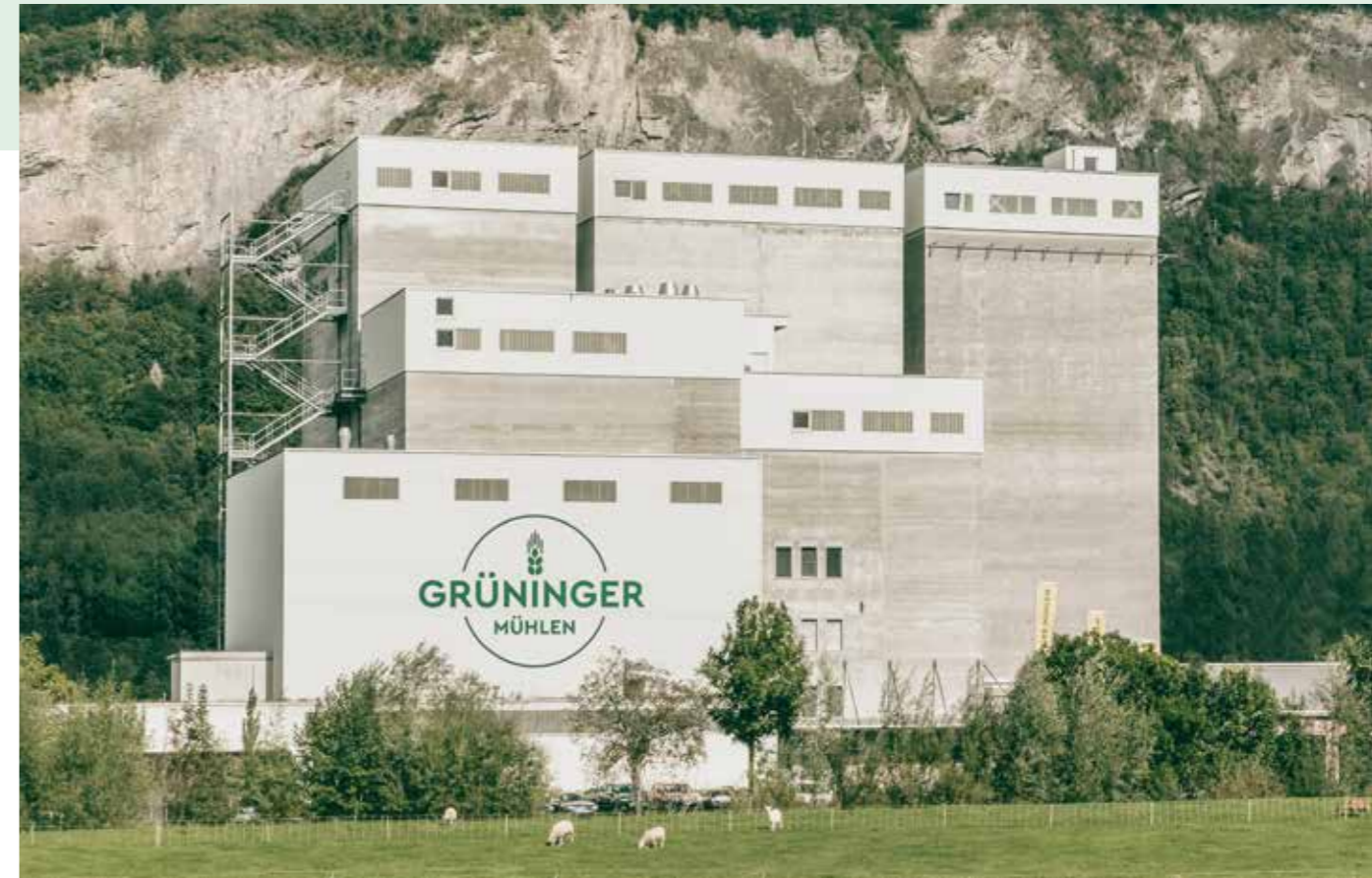
Weichweizenmühle in Flums mit einer Leistung von 120t/24h
