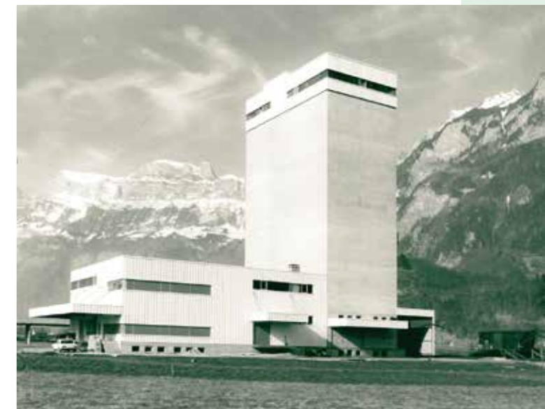
Inbetriebnahme der Futtermühle 1976
